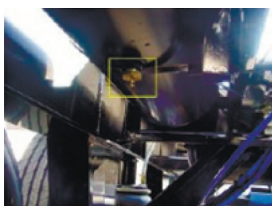
Очистка водоотводящего клапана
